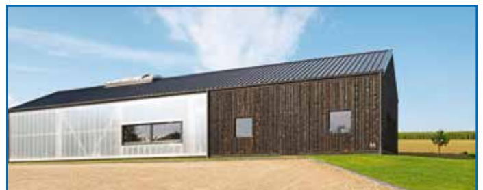
Ein Preis ging an den Neubau einer Gewerbehalle in Baar (Schwaben)
